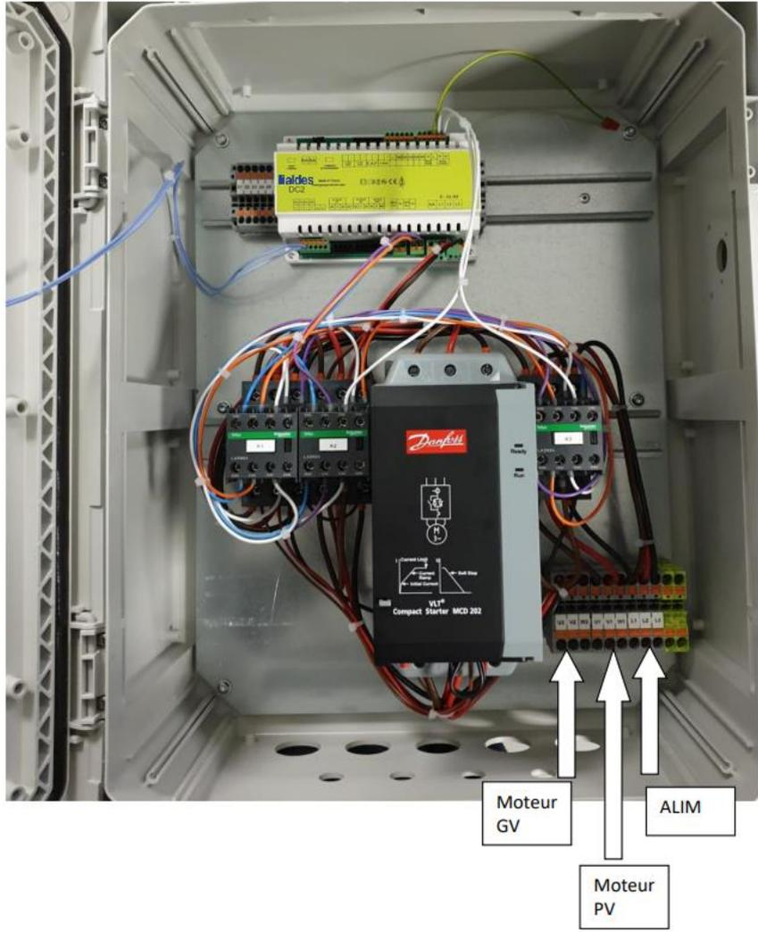
*Raccordement de la puissance : AXONE Micro III 2V/DES-BI DPROG*
